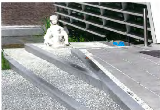
Waar ze elkaar snijden zijn de vlakken afgewerkt met gegalvaniseerde stalen randen, die over betonnen muurtjes zijn gevouwen. De randen hellen over, net als de aanbouw. Het split raakt in de loop der jaren met elkaar vermengd, maar de grens tussen de kleuren mag wel vervagen vindt Baljon.
