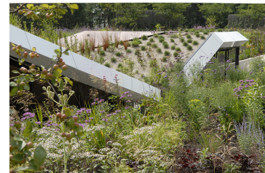
Hier en daar steken de daken van de uitgangen van de parkeerkelder boven de beplanting uit. Als kieuwen brengen ze licht en lucht in de garage. De planten die op deze daken groeien zijn taaier, meer droogteresistent en groeien trager: Koeleria glauca , Pennisetum alopecuroides 'Little Bunny', Origanum laevigatum 'Herrenhausen' en Sedum 'Matrona'. Het duurt hier langer voordat de bodem is bedekt.
